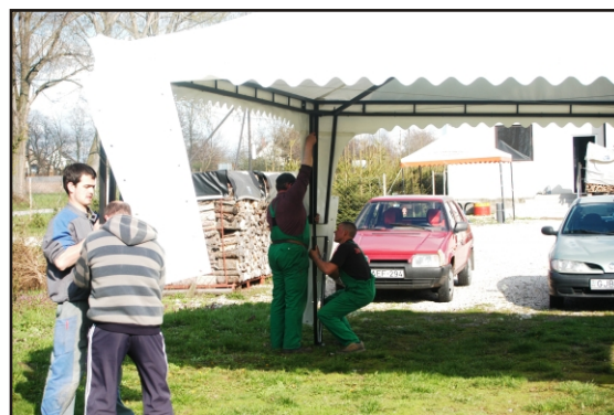
8. Tetőszerkezet másik oldali felemelése, lábtoldó beillesztése, összecsavarozása
