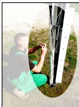
8. Tetőszerkezet másik oldali felemelése, lábtoldó beillesztése, összecsavarozása
