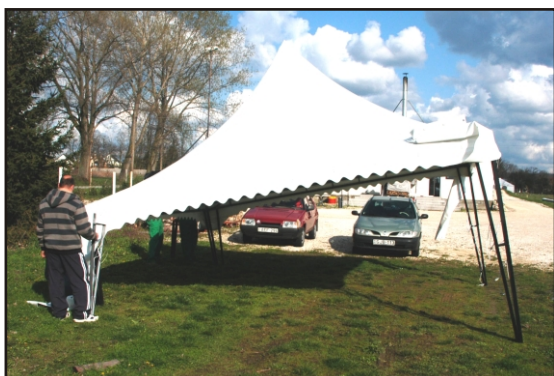
8. Tetőszerkezet másik oldali felemelése, lábtoldó beillesztése, összecsavarozása
