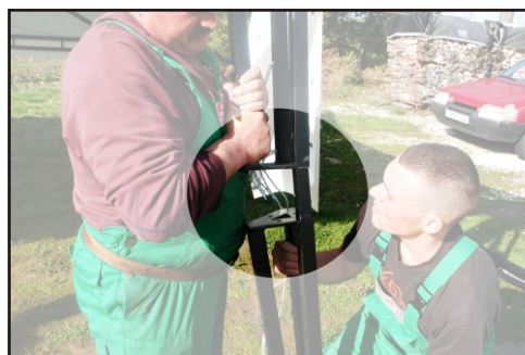
7. Tetőszerkezet egyoldali felemelése, lábtoldó beillesztése
