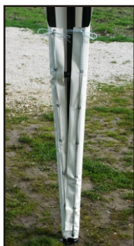
8. Tetőszerkezet másik oldali felemelése, lábtoldó beillesztése, összecsavarozása
