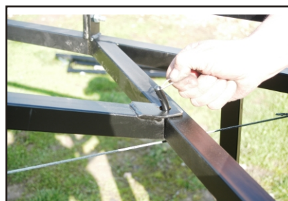
4.1 Tetőszerkezet tartók biztonsági sasszegeinek behelyezése
