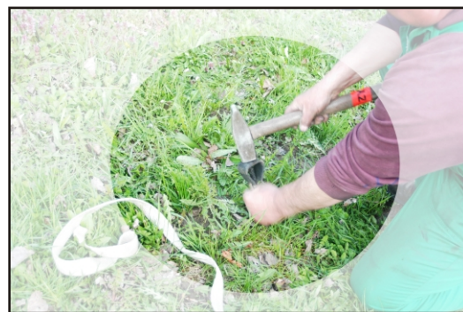
10. Rögzítő cövek leütése
