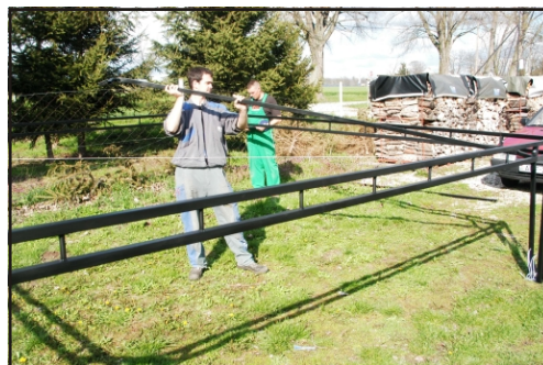
4. Tetőszerkezet tartók összeillesztése
