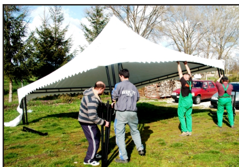
7. Tetőszerkezet egyoldali felemelése, lábtoldó beillesztése
