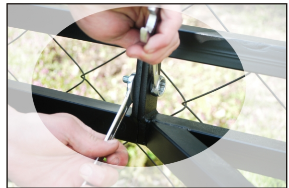
2.2 Keretszerkezet illesztéseinek összecsavarozása
