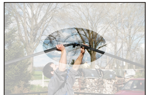
4. Tetőszerkezet tartók összeillesztése
